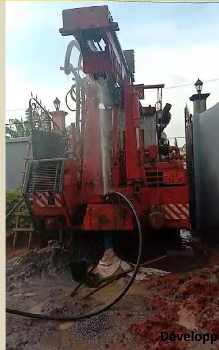
Développement par soufflage à air lift
